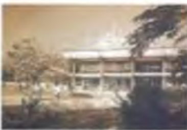
La Casa Blanca, sede administrativa de la institución.
