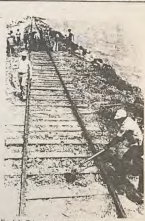
Uno de los Tajamares de Bocas de Ceniza, donde está el gran problema para el puerto de Barranquilla.
