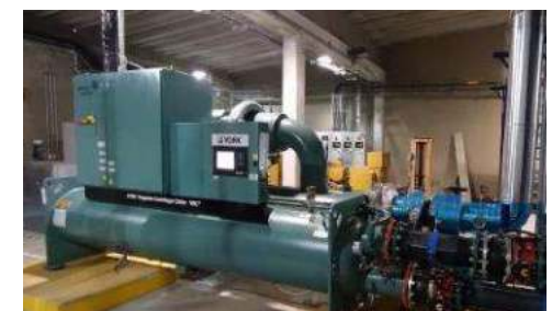
Ampliación de capacidad Central de Frío 2 - Nuevo Chiller 2 (I semestre)
